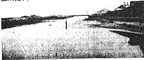
請戸港内 手前が港奥、向が外海に通じる。左堤防の外を流れる請戸川から河川水の一部が流入する。
