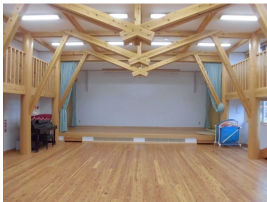
遊戯室の天井
