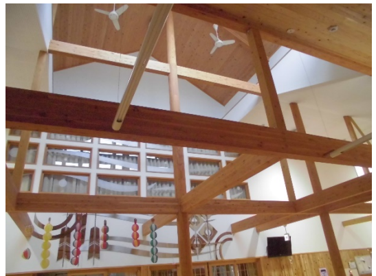
遊戯室の天井
