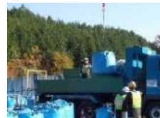
除去土壌等の車両積込状況
