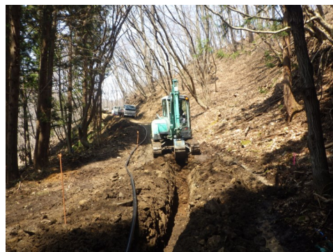
芦ノ原の導水管工事着手
