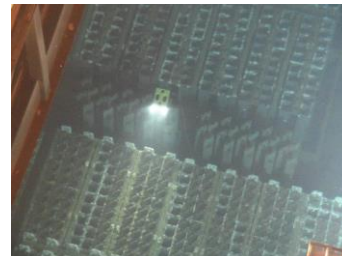
遠隔操作水中ロボットによる調査作業の様子
