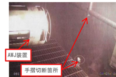
手摺（縦部）の切断状況
