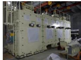
鉄セル本体据付作業状況
