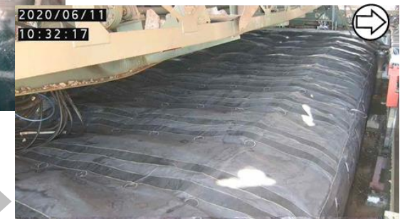
養生バックへのエアモルタル※充填が完了
