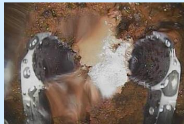
ペDESTAL内堆積物の把持状況
