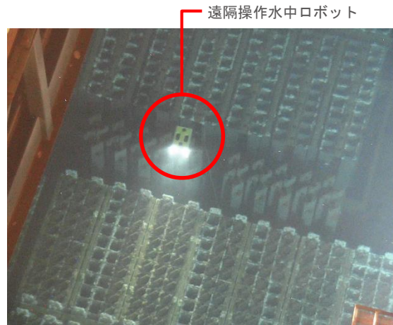
遠隔操作水中ロボットによる調査作業の様子
