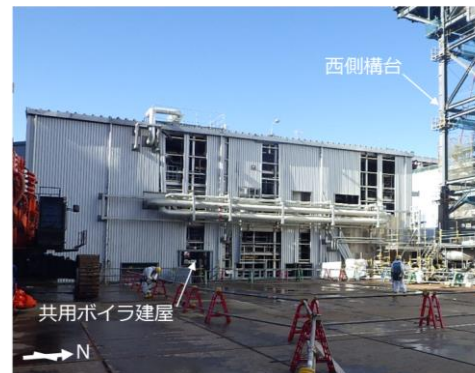
共用ボイラ建屋解体前
