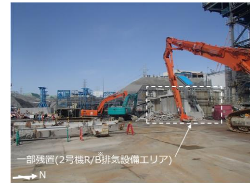
共用ボイラ建屋解体後
