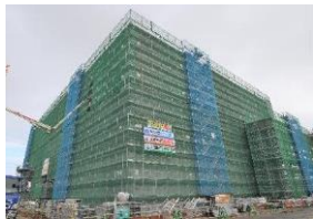
建屋工事全景写真
