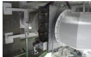
換気・空調設備の工事状況
