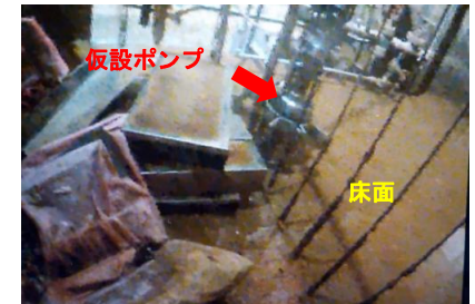
2号機Rw/B地下1階(最下階)の床面露出状況
