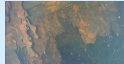
ペDESTAL内側の状況
