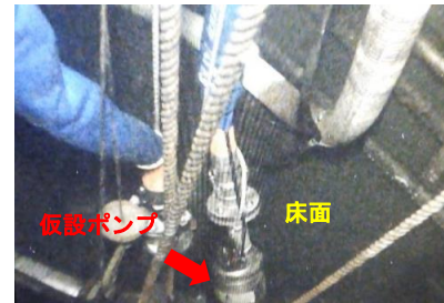
2号機T/B地下1階(最下階)の床面露出状況
