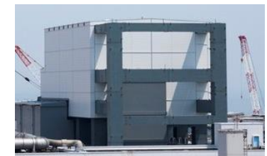
4号機原子炉建屋外観
