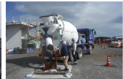
内部充填作業中
