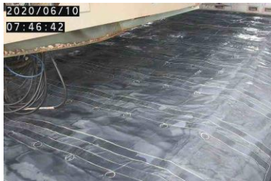
養生バッグエア注入後の使用済燃料プールの状況(6月10日撮影)
