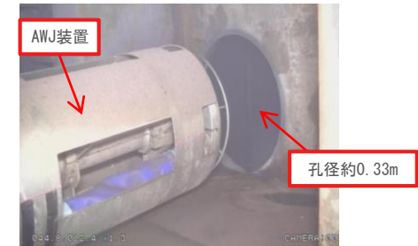
孔径約0.33m孔の貫通状況
