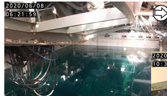
養生バック投入前の使用済燃料プールの状況
