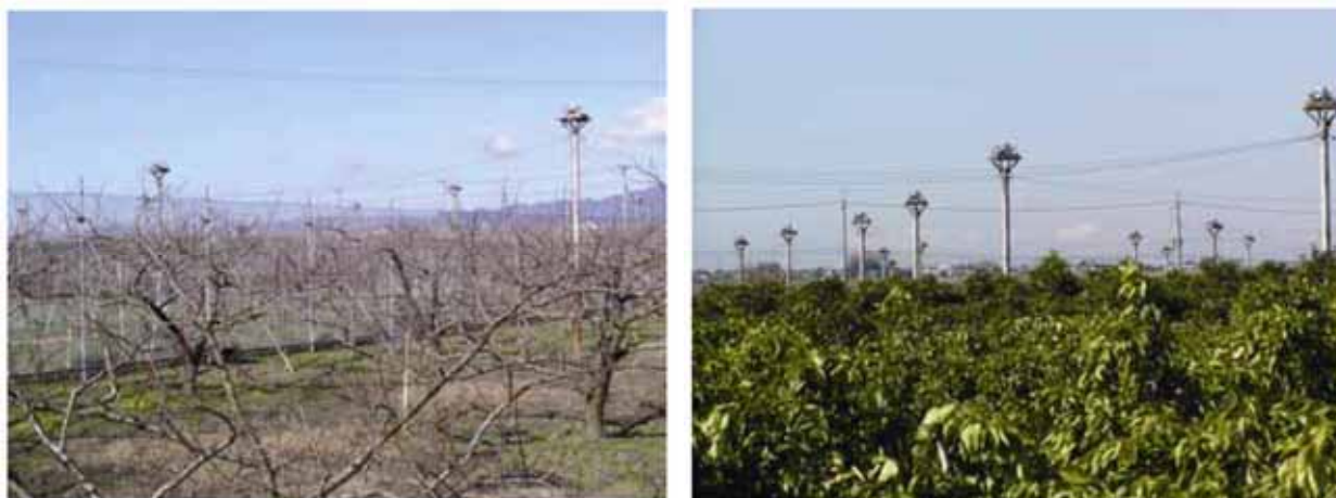
図-24.4 防霜ファン設置状況
