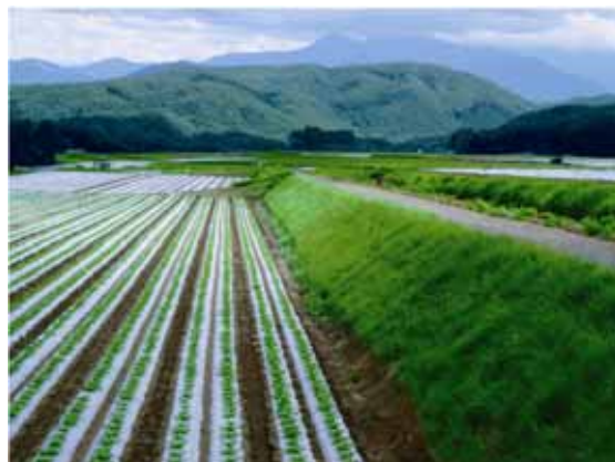
写真-6.1 法面の緑化の状況
