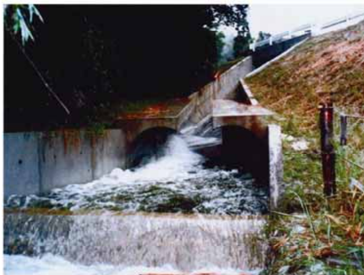
図-20.18 宮崎市瓜生野北ノ迫地区：ため池洪水吐での使用事例 (屈曲角度 45°)
