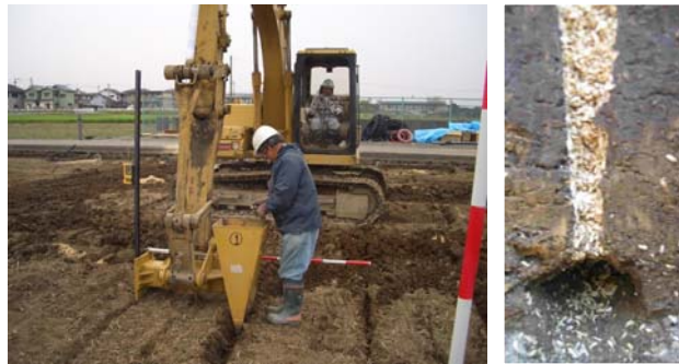
写真-26.1 アーム式補助孔形成装置による施工と断面
