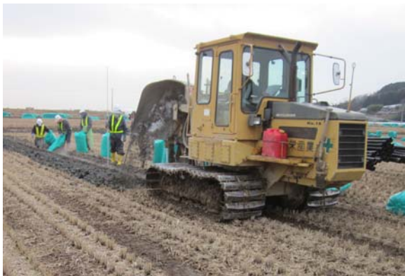
写真-19.1 トレンチャ工法の施工状況
