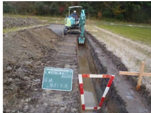
写真-19.2 バックホウ工法の施工状況
