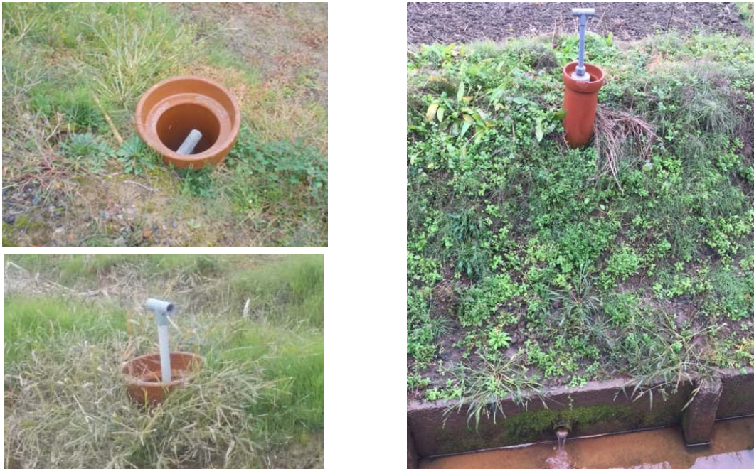
写真-21.1 水閘の保護管事例
