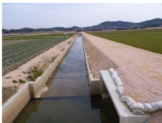
写真-28.1 排水路（底面部）のライニング施工事例
