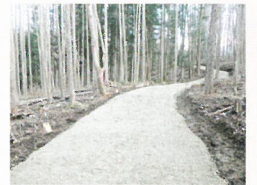
作業道の整備状況
