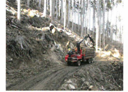
林内作業路の開設
