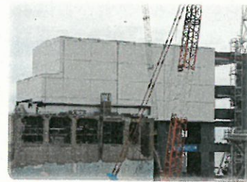
燃料取り出しカバーが設置された4号機
