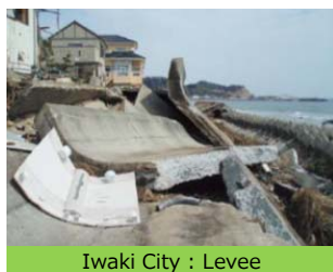
Iwaki City : Levee
