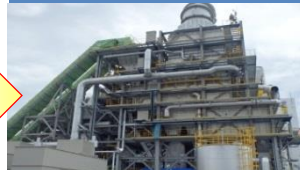
临时焚烧设施
