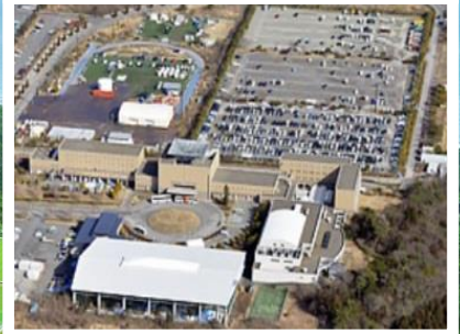
刚刚发生地震之后的样子
