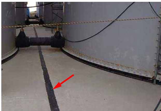
コンクリート基礎打継ぎ目の止水シール
