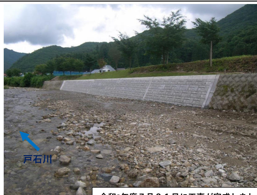
令和2年度7月31日に工事が完成しました
