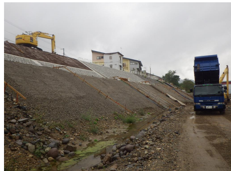
施工状況（令和2年10月5日撮影）
