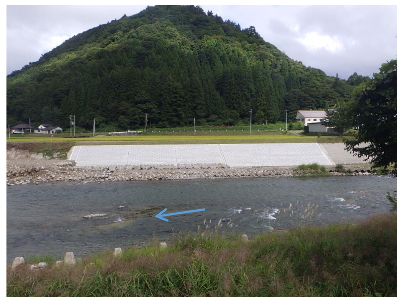
令和2年度9月14日に工事が完成しました
