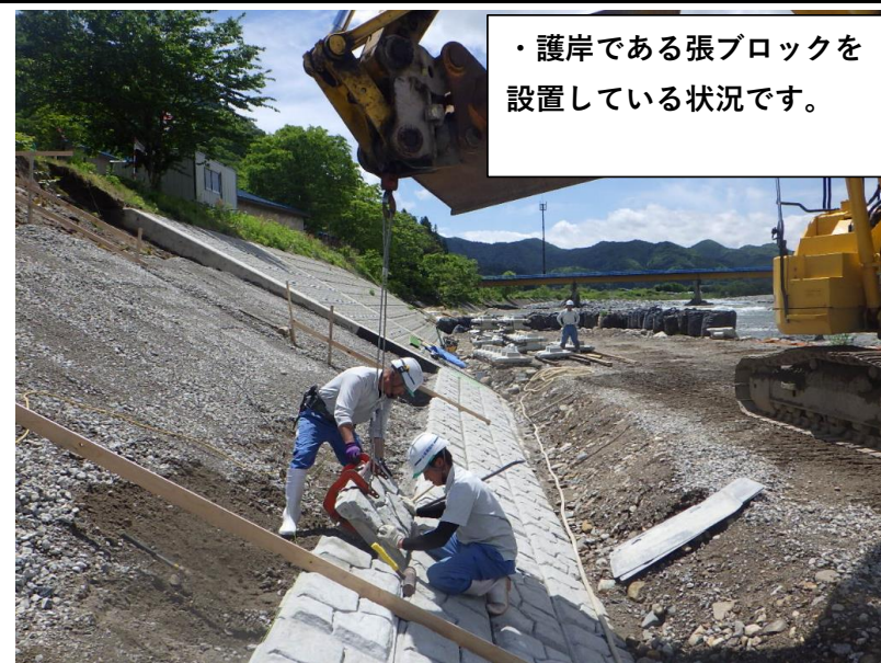
施工状況（令和2年5月27日撮影）
