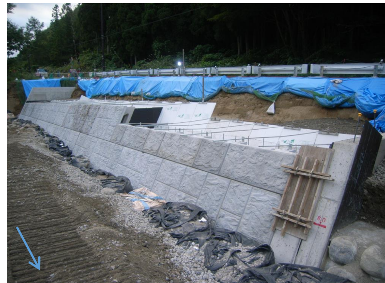
施工状況（令和2年10月3日撮影）
