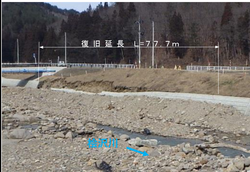
被災状況（令和2年3月12日撮影）
