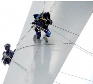
株式会社ユーラス滝根小白井WF様でのブレード点検の様子
