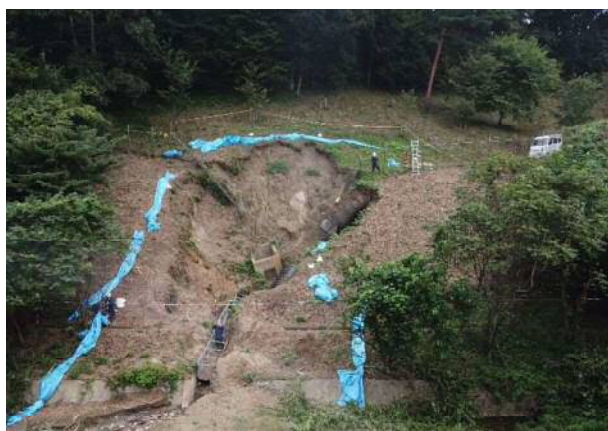
公園施設被災状況
