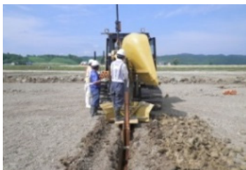
暗渠排水の整備
