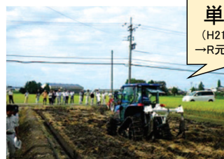
サブソイラによる 明渠・暗渠の施工
