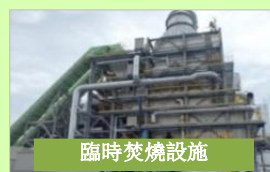
災害廢棄物的處理現場
