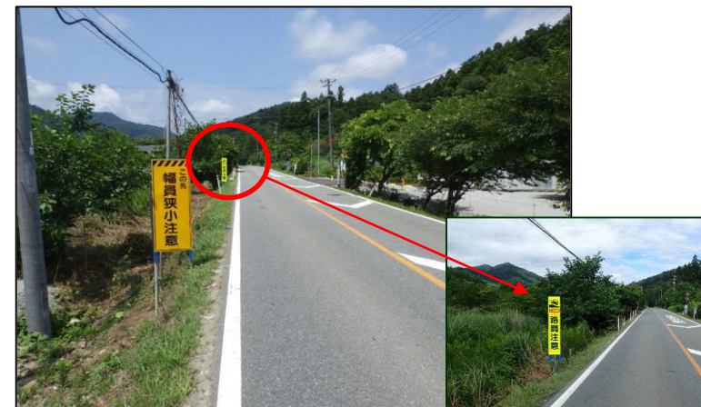
図 事故後の看板設置状況
