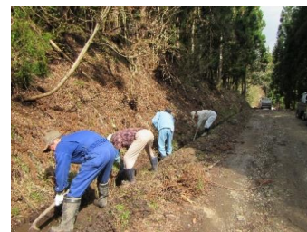
（水路の泥上げ）
