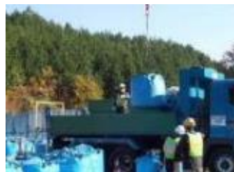
除去土壌等の車両積込状況
