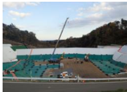
埋立処分施設の状況
