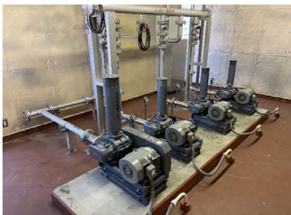
農業集落排水事業 (施設整備) 滑津地区
