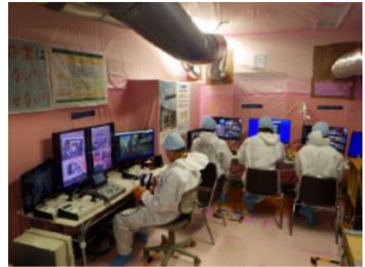
＜遠隔操作室（3号機S / B内）＞
