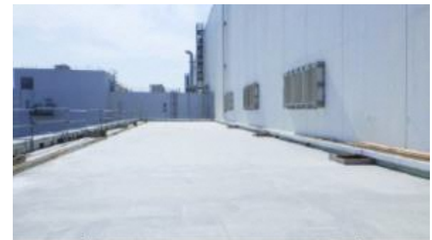
<コンクリート打設後>
