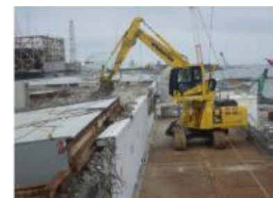
＜ガレキ小割作業状況＞
