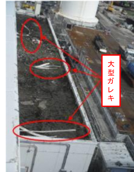
<大型ガレキ撤去前>
