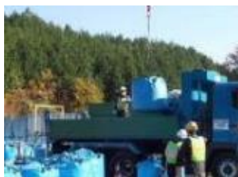
除去土壌等の車両積込状況
