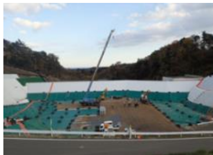
埋立処分施設の状況
