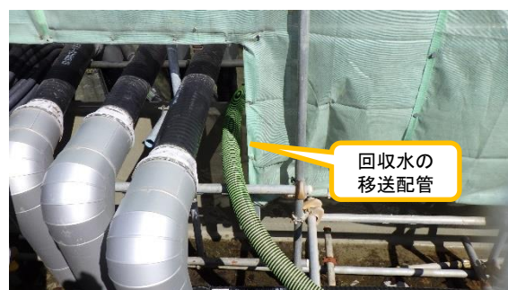
(写真3-2) 水中ポンプ回収水のK2タンクエリアへの移送状況② (K2タンクエリア南西端、南側から撮影)
