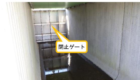
(写真2) 閉止ゲート下流側の状況 (港湾側から撮影)
