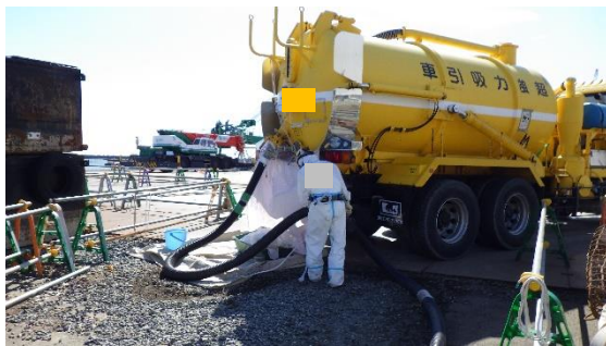
(写真1-3) 物揚場における吸引車による回収状況 (物揚場北西側から撮影)
