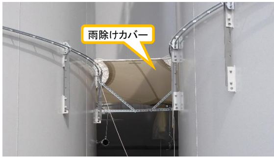
(写真3) 雨除けカバーの設置状況
