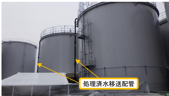
(写真4) 処理済水移送配管の設置状況
