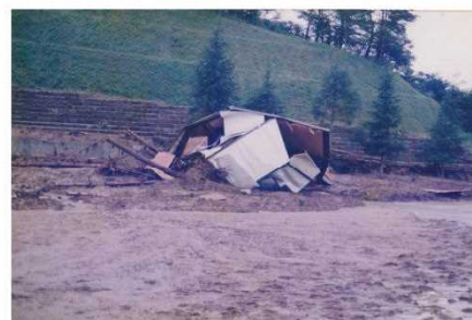
全壊した体育倉庫
