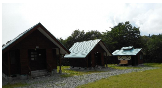
【図 3-13】 宿泊棟は3棟並んでいる
