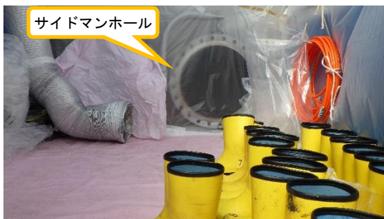
(写真3-2) 前室内部の状況
