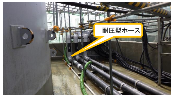
(写真5-2) K2タンクエリア南西側付近 (同左)
