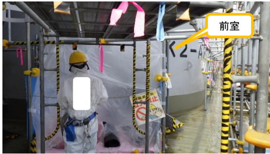
(写真3-1) K2タンクエリア 前室の設置状況
