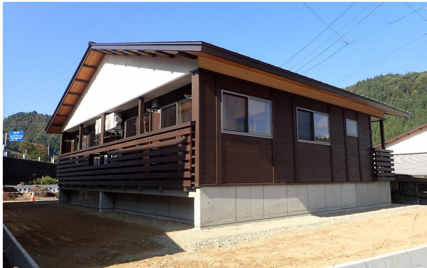
白河市の木造仮設住宅（壁パネル工法）を三島町の移住定住促進住宅として再利用
