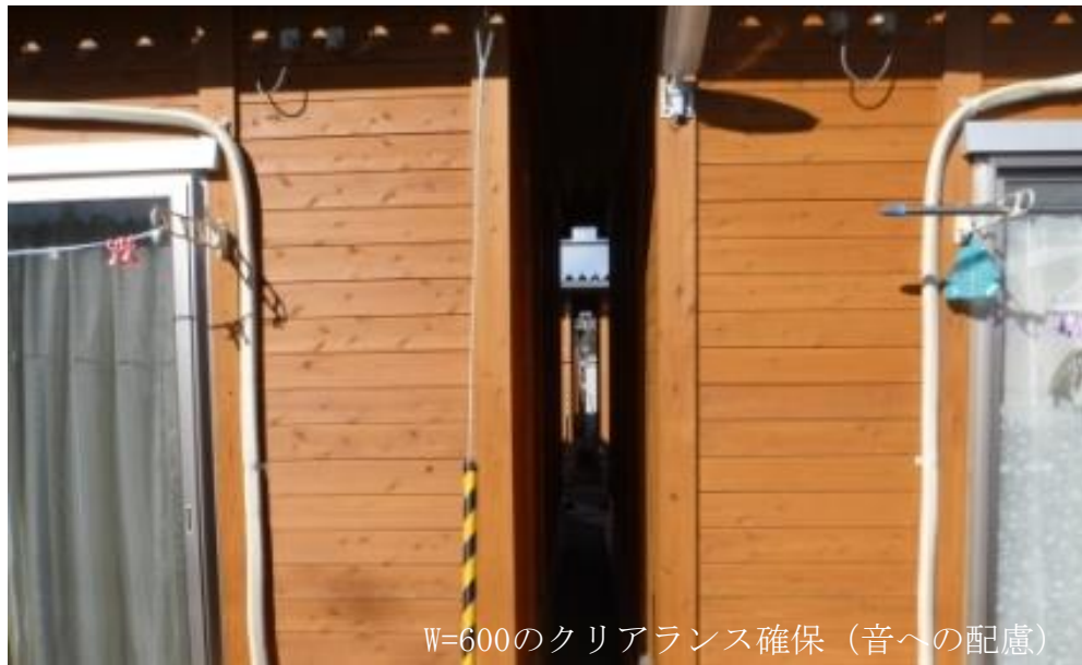
住戸間に空間を設けた応急仮設住宅（音への配慮）
