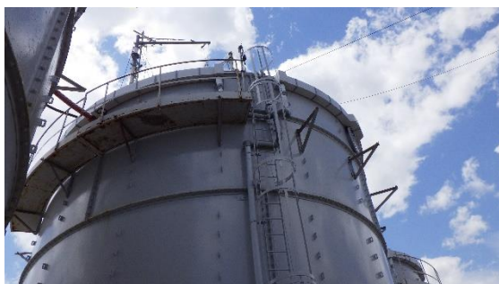
(写真3-2) 撤去作業中のタンクの状況
