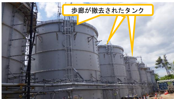
(写真3-1) 歩廊が撤去されたタンクの状況
