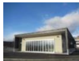
猪苗代水環境センター
