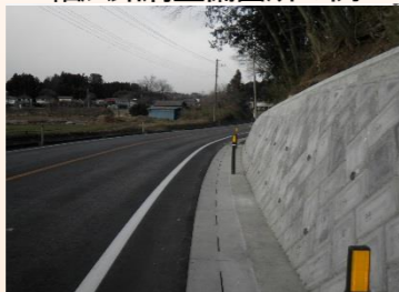
国道294号 (白河市・白坂工区)
