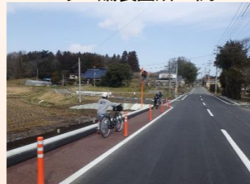
県道須賀川矢吹線 (矢吹町・天開工区)
