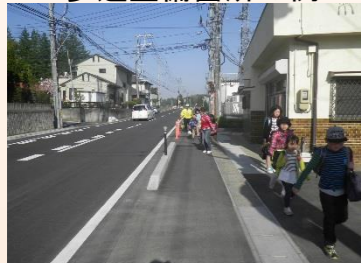
矢吹天栄線 (矢吹町・花咲工区)
