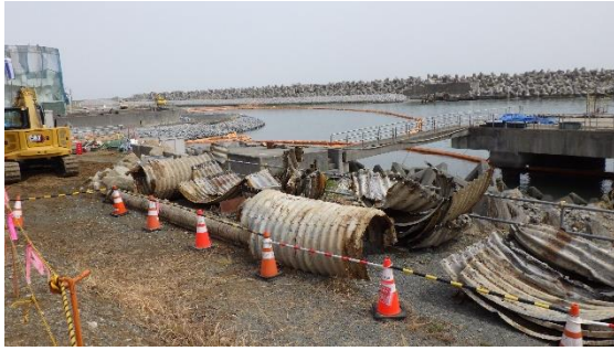
(写真4-1) 撤去された廃棄物等の仮置状況 (令和3年3月30日時点)
