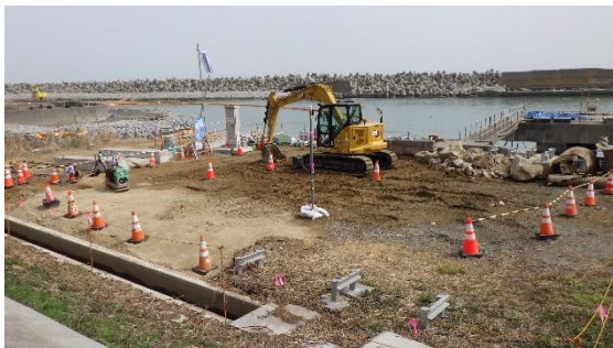
(写真3-1) 下流側到達立坑建設現場の状況 (令和3年3月30日時点)
