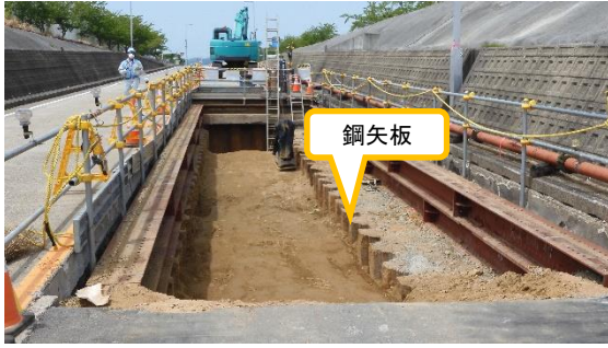
(写真1) 支障物撤去後の埋め戻し状況 (上流側到達立坑) (東側から西側に向かって撮影)
