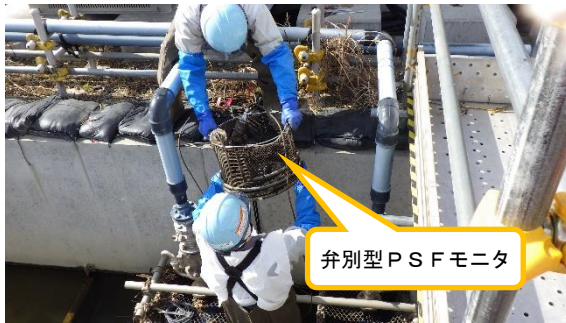
(写真1-2) 物揚場排水路での弁別型PSFモニタ据付け作業の状況 (南側から撮影)
