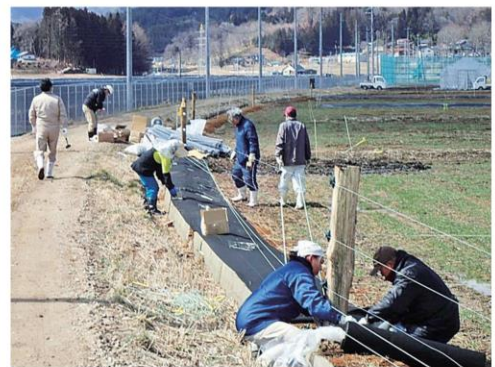
図1 防草シートによる対策
