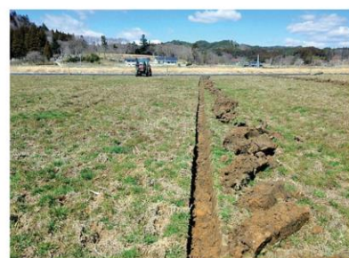
図5 溝掘機による明きよ設置
