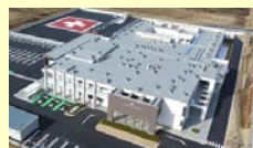
福岛县双叶医疗中心附属医院
