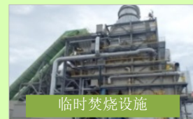
灾害废弃物处理的现场
