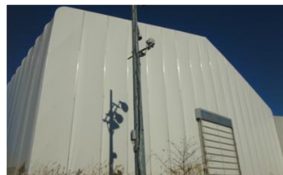
一時保管エリアA1テント俯瞰
