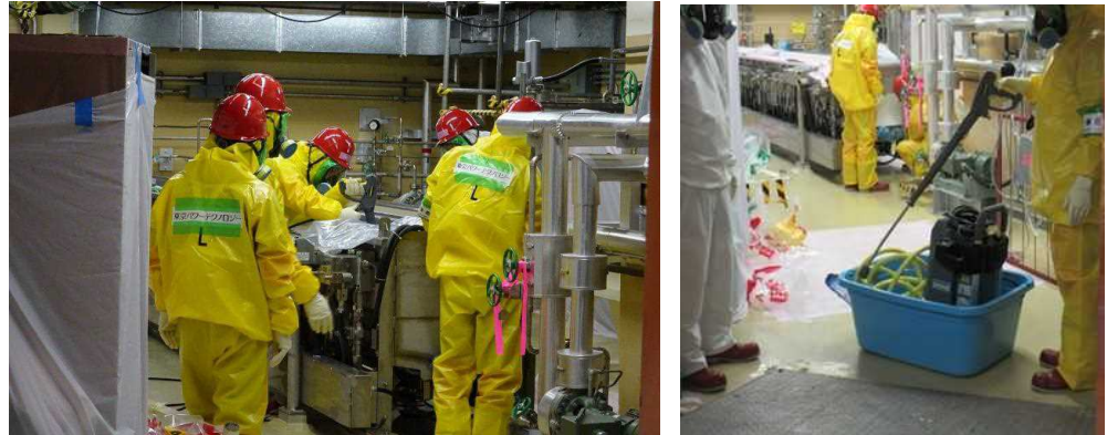
【汚染の除去作業の様子と作業に用いる高圧洗浄機器】
