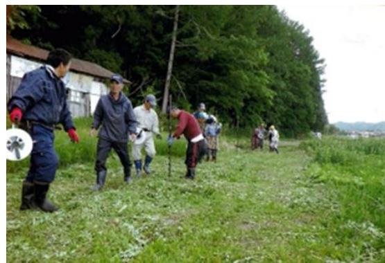
写真 電気柵設置作業
