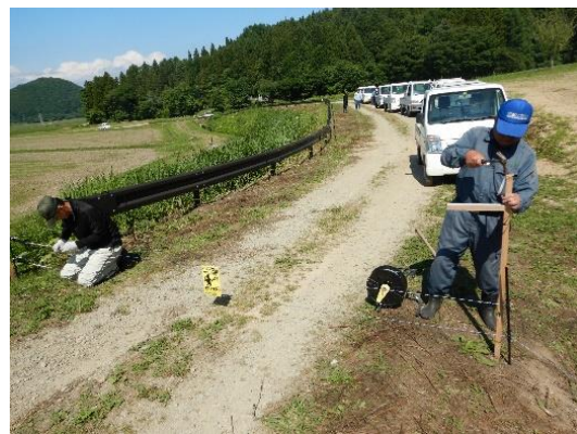
写真2 電気柵の設置
