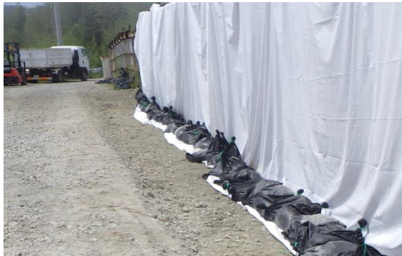
(写真 2-3) 地表面の剥ぎ取り状況 (拡大)
