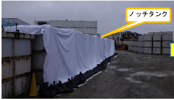
(写真 2-1) ノッチタンク周辺の地表面の状況 (令和 3 年 7 月 9 日撮影)
