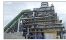
临时焚烧设施
