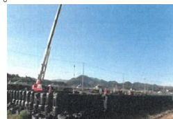
临时放置场所的样子
