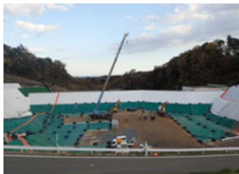
埋立処分施設の状況
