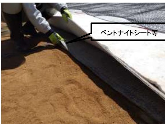
不透水性層の施工状況
