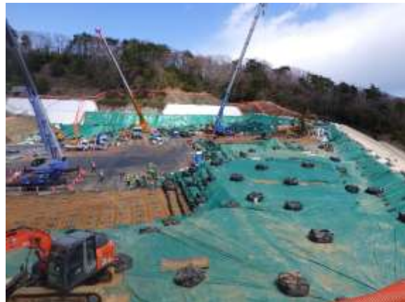
埋立地内(下流側)の状況確認
