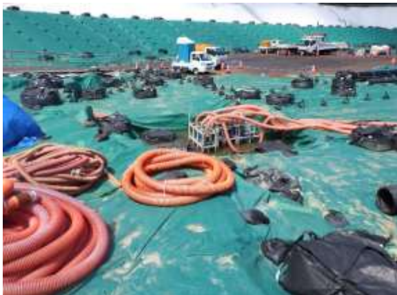
埋立地内(上流側)の状況確認
