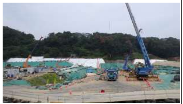
埋立地内の状況確認
