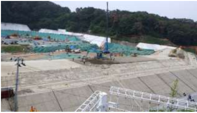
土堰堤築堤の状況確認
