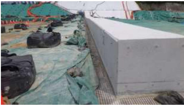
仕切堤施工の状況確認
