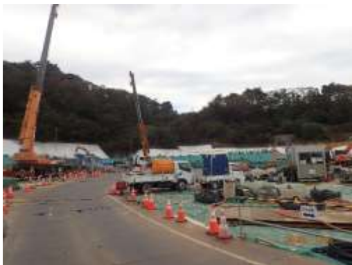
埋立地内(下流側)の状況確認
