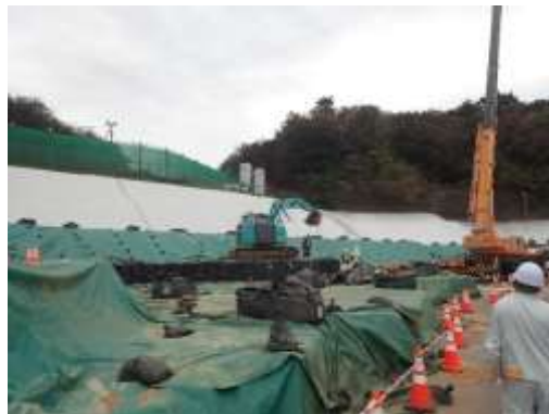
埋立地内(上流側)の状況確認
