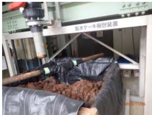
脱水汚泥の処理状況確認
