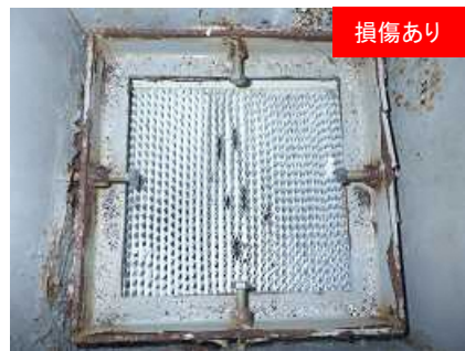
増設ALPS 排水タンク (再掲)
