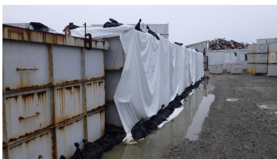
(写真5) ノッチタンクの状況
