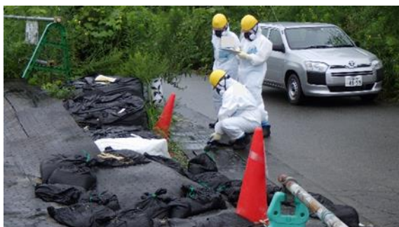
(写真4) モニタリングの実施状況
