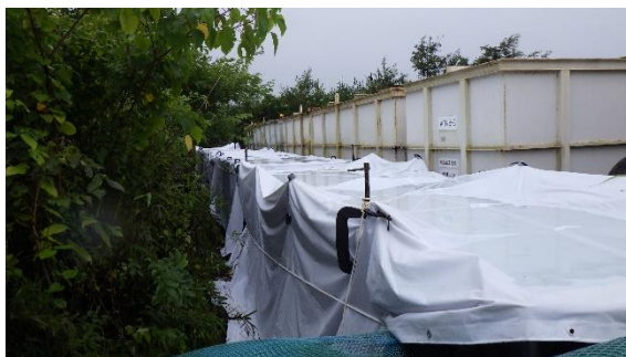
(写真3) シート養生されたノッチタンクの状況
