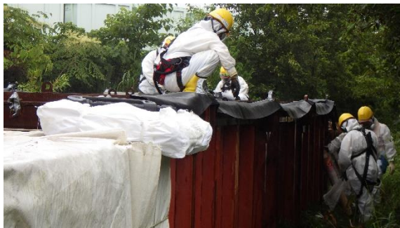
(写真2) シート養生作業の状況
