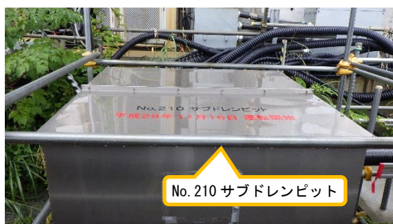
(写真2-1) No. 210 サブドレンピットの状況
