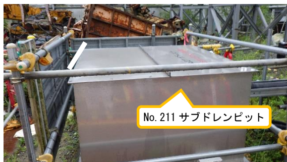
(写真2-2) No. 211 サブドレンピットの状況
