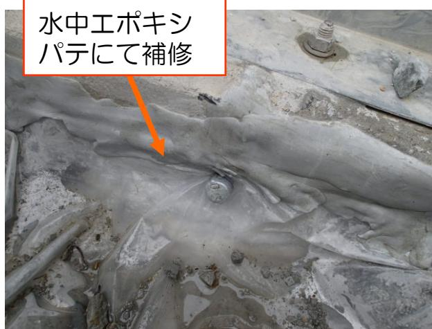
【H5 西側の漏洩箇所の補修状況】
